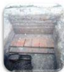
Antiguo piso pozo 6B
