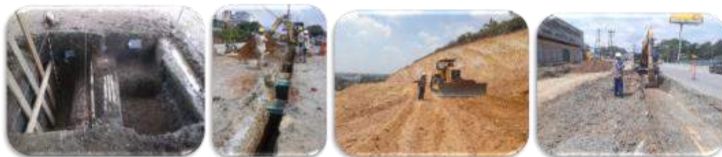
Foto No 38, 39, 40, 41 Labores de excavación y monitoreo arqueológico Fuente: Subdirección de Investigaciones
